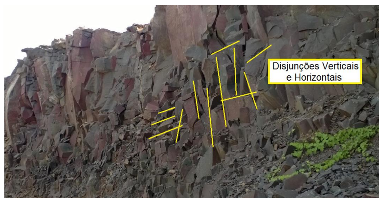
Figura 4.1.17 - Parede rochosa da Pedreira SJ com Disjunções verticais e horizontais.
