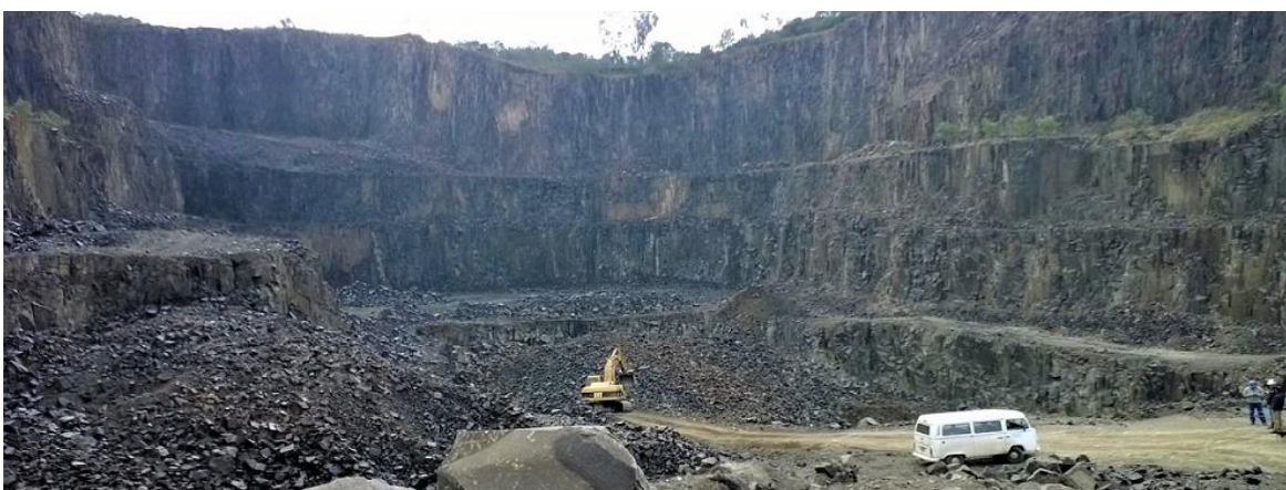
Figura 3.1.6 - Pedreira CAP sob vista frontal.
