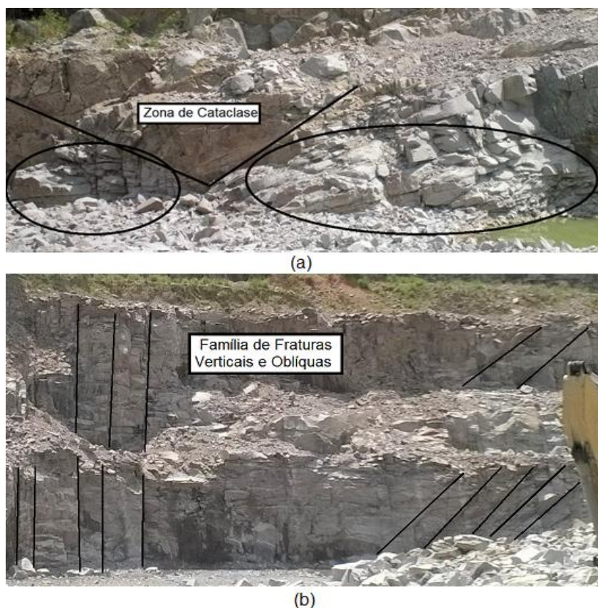
Figura 4.1.10 - Parede rochosa da Pedreira SBS. a) Zona de Cataclase em evidência e fragmentação do material rochoso; (b) Família de fraturas verticais e oblíquas.
