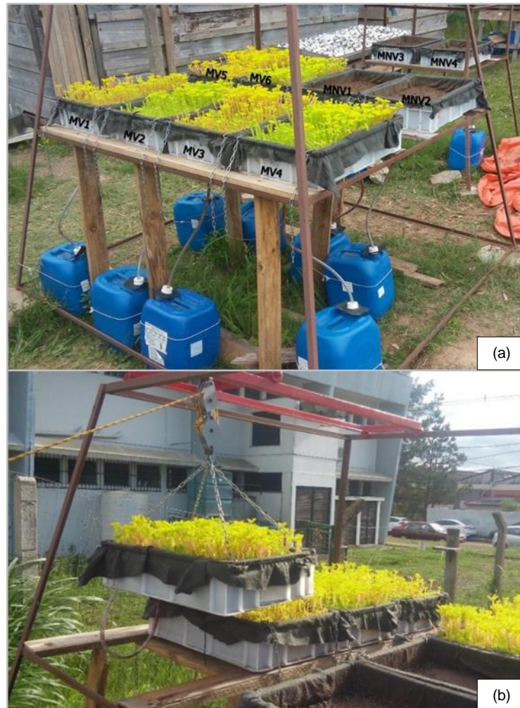
Figura 7 - (a) conjunto experimental instalado com a identificação dos módulos. (b) sistema de polias para a suspensão dos módulos.
