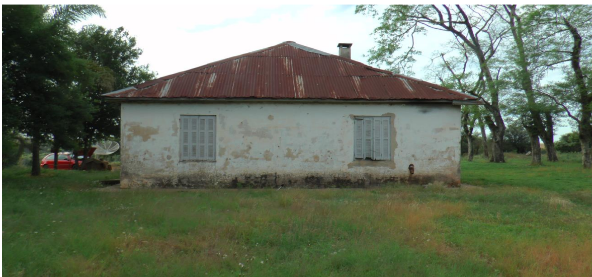
Figura 04 – Galpão da Fazenda
