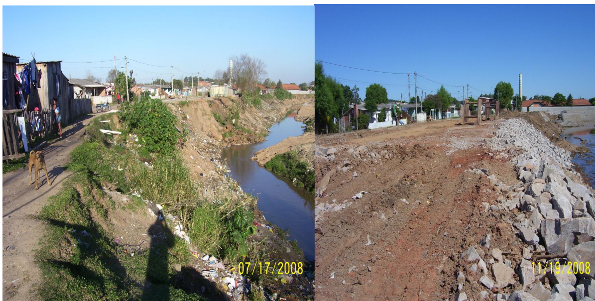
Figura A5: Antes de Retirada das Casas da Área de Risco na Vila Lúcia.
