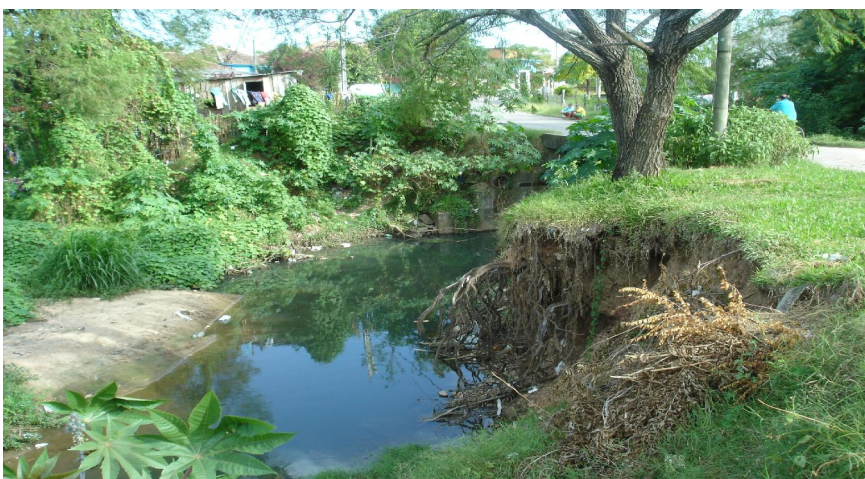
Figura A10, A11 e A12: Áreas de risco de deslizamento, escorregamento, enchentes e desbarrancamento nos Bairros Itararé e Carolina em Santa Maria.
