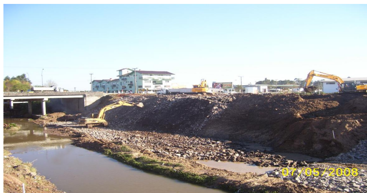
Figura 8: Modificação do leito do Arroio Cadena na Vila Lidia.
