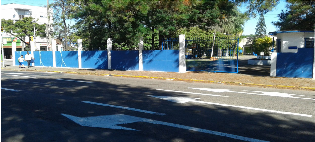
Figura 13 – Fachada e entrada da escola pela Rua Appel. Fonte: Pamela Fleck/2015.
