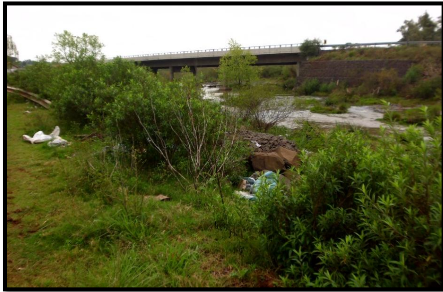
Figura 8 - Ponte BR 377, resíduos sólidos depositados as margens da Sanga da Divisa. Quaraí, RS. Foto: MOREIRA, Galidulcidio – 2014.
