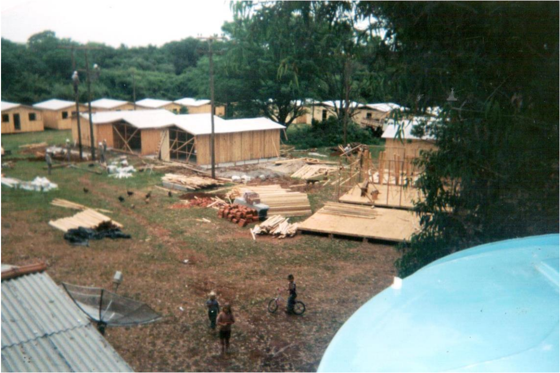
Fotografia: Agrovila em construção – reassentamento Tupã I/ Cachoeirinha (Tupanciretã/RS)
