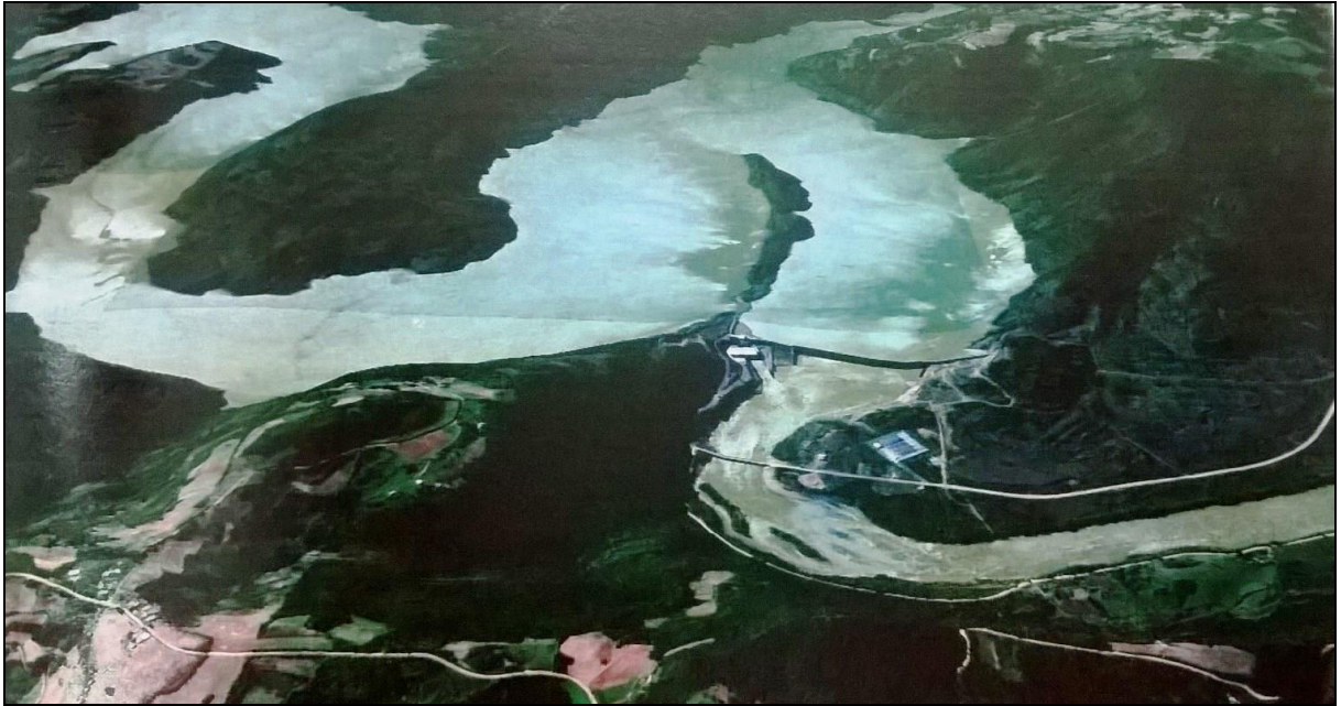
Figura 04- Vista panorâmica da Usina Hidrelétrica Dona Francisca e parte da bacia de acumulação. Fonte: Google Earth ( apud NOAL, 2012, p. 49).
