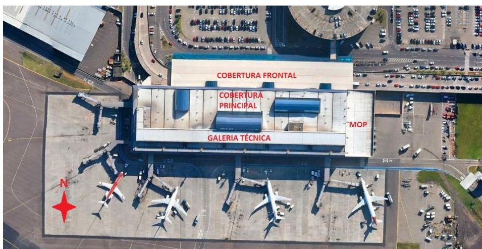
Figura 08: Cobertura do Terminal de Passageiros.
