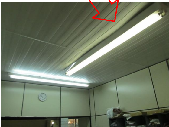
Figura 6 – Forro da Sala de Registrados
