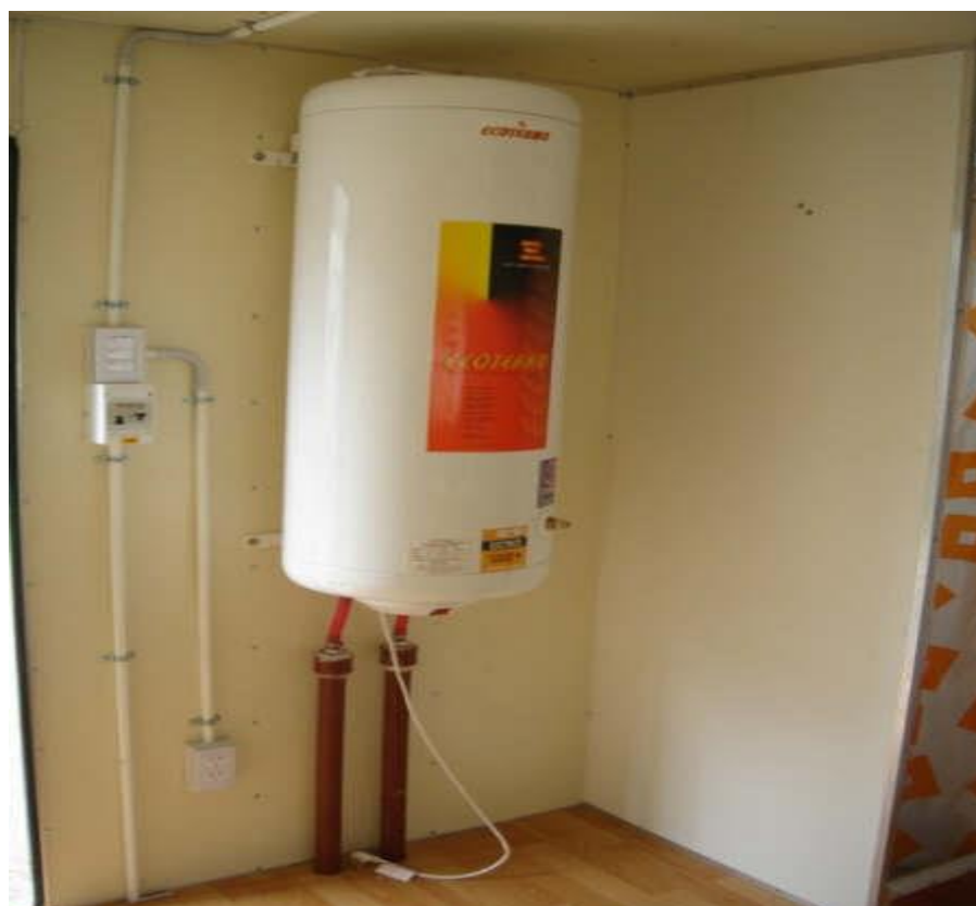
Figura 6 – Termotanque elétrico, aquecimento através de resistência.
