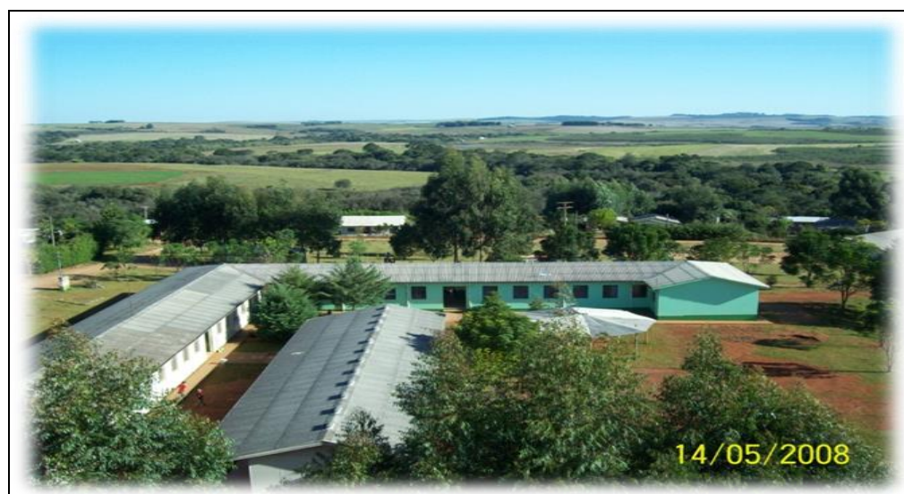
Figura 10 – Vista aérea da Escola
