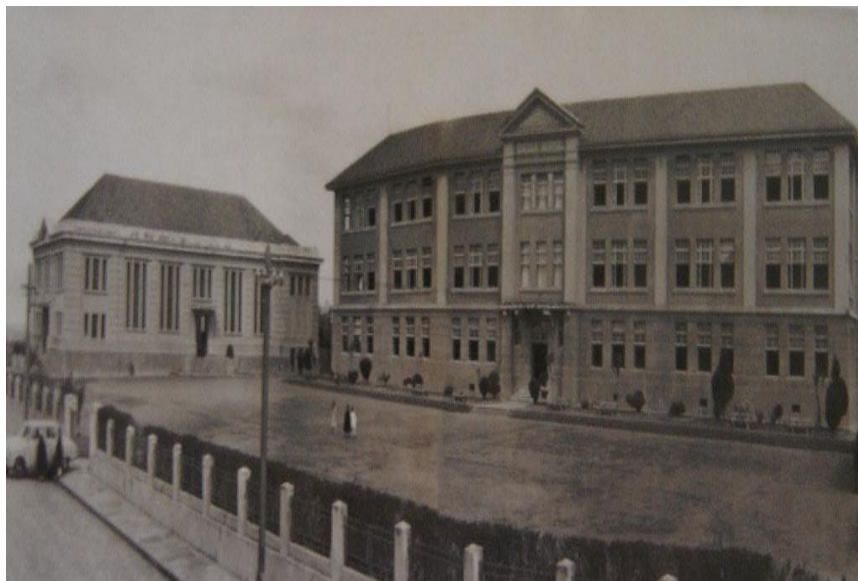
Complexo do Instituto Estadual de Educação Olavo Bilac, década de 1940. Santa Maria, Rio Grande do Sul.
