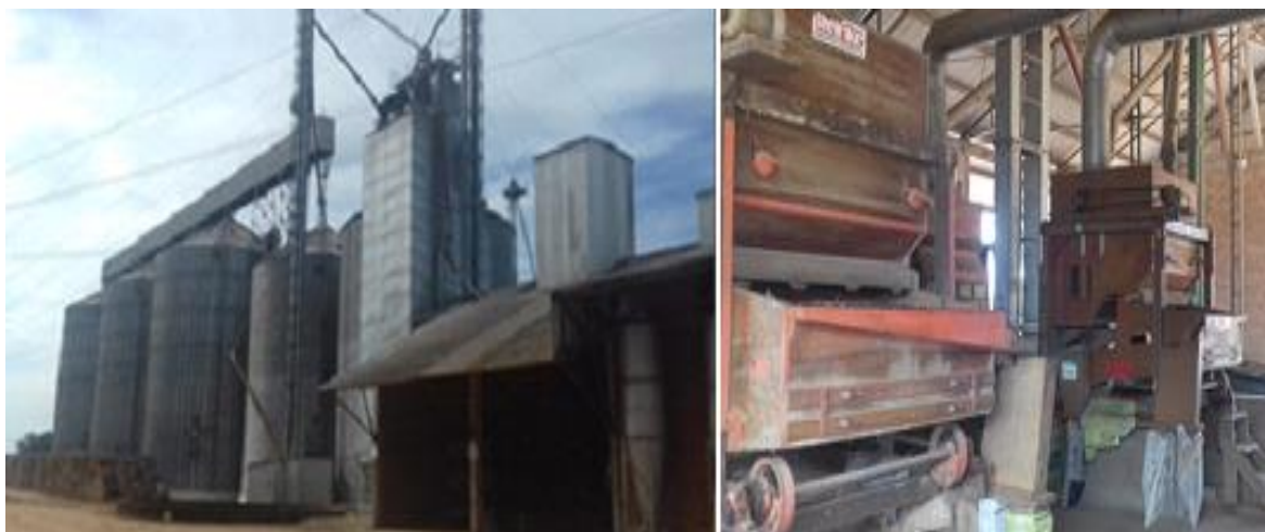
Figura 20 - Vistas da estrutura e equipamentos do Armazém 1 (Cooperativa Cotriel).
