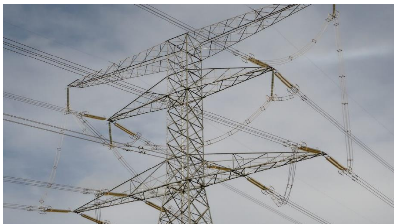
Figura 4 – Estrutura de transposição
