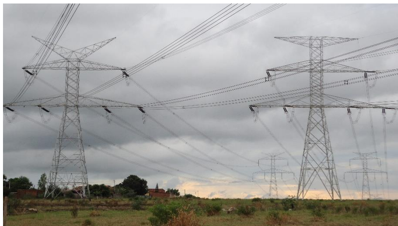
Figura 3 – Estrutura de ancoragem
