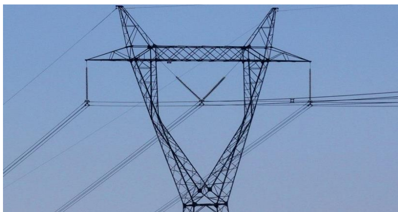
Figura 2 – Estrutura de suspensão
