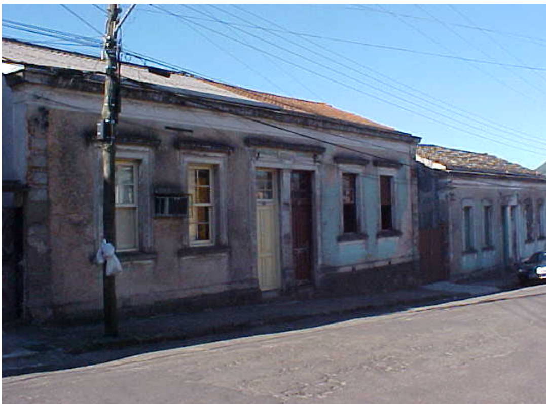
Foto 9 – Vista da fachada do imóvel, em primeiro plano, à direita
