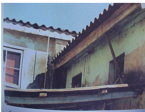
Foto 21 – Pátio central. As telhas, em baixo Pertencem ao telheiro do tanque.
