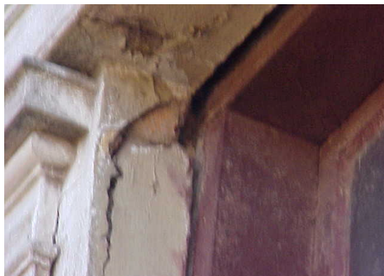
Foto 12 – Detalhe da parte superior da porta.
