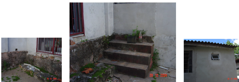
Foto 46 – Escada que dava acesso ao vestíbulo.
