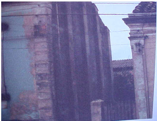
Foto 17 – Cunhal e parede lateral.
