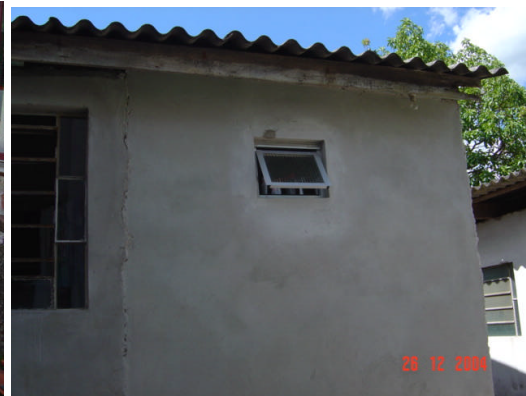
Foto 45 - Pátio interno - bloco posterior.
