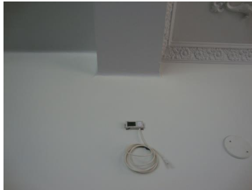
Figura 28 - Registrador instalado na Sala de Estar C.
