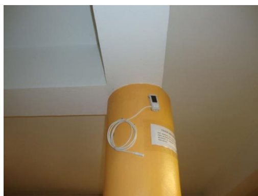
Figura 26 - Registrador instalado na Sala de Estar A.
