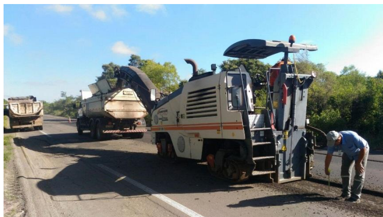
Figura 5 – Vista do trecho e máquina fresadora Wirtgen W 100f
