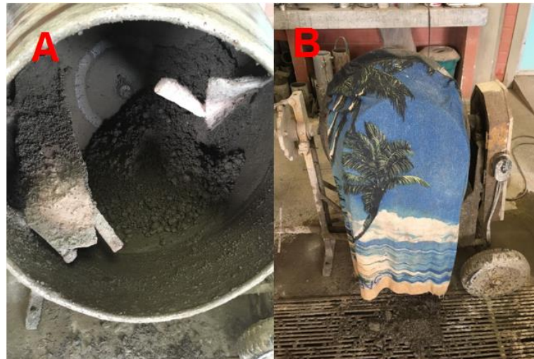
Figura 13 – (A) Mistura dos materiais em betoneira; (B) Proteção contra perda de umidade
