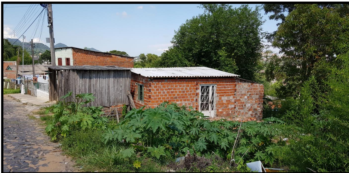
Figura 47 - Residência construída sobre o aterro onde houve o deslizamento.
