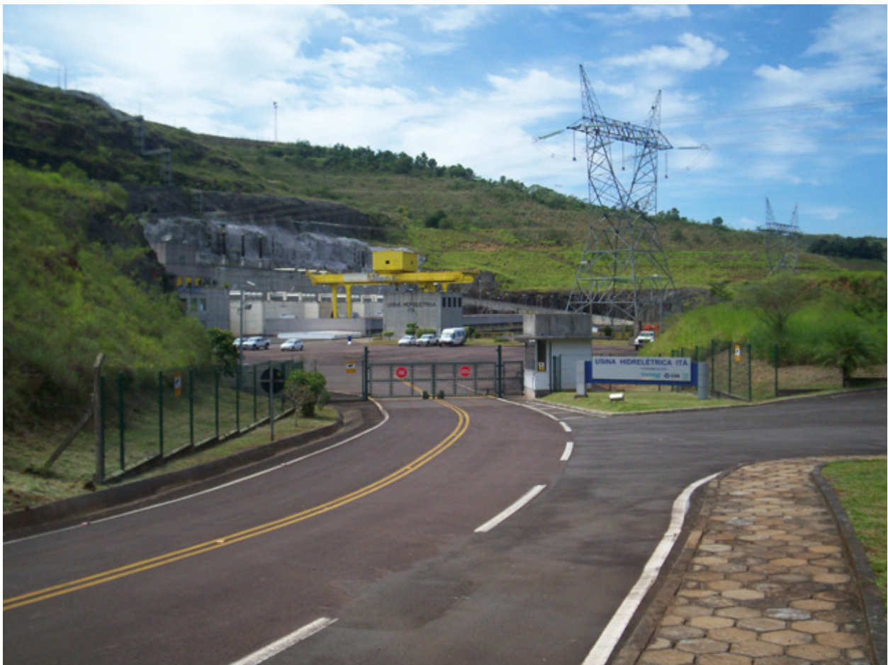
Figura 2.7 - Vista frontal da Casa de Força - Usina Hidrelétrica de Itá. Imagem: Adroaldo Dias Robaina e Marcia Xavier Peiter
