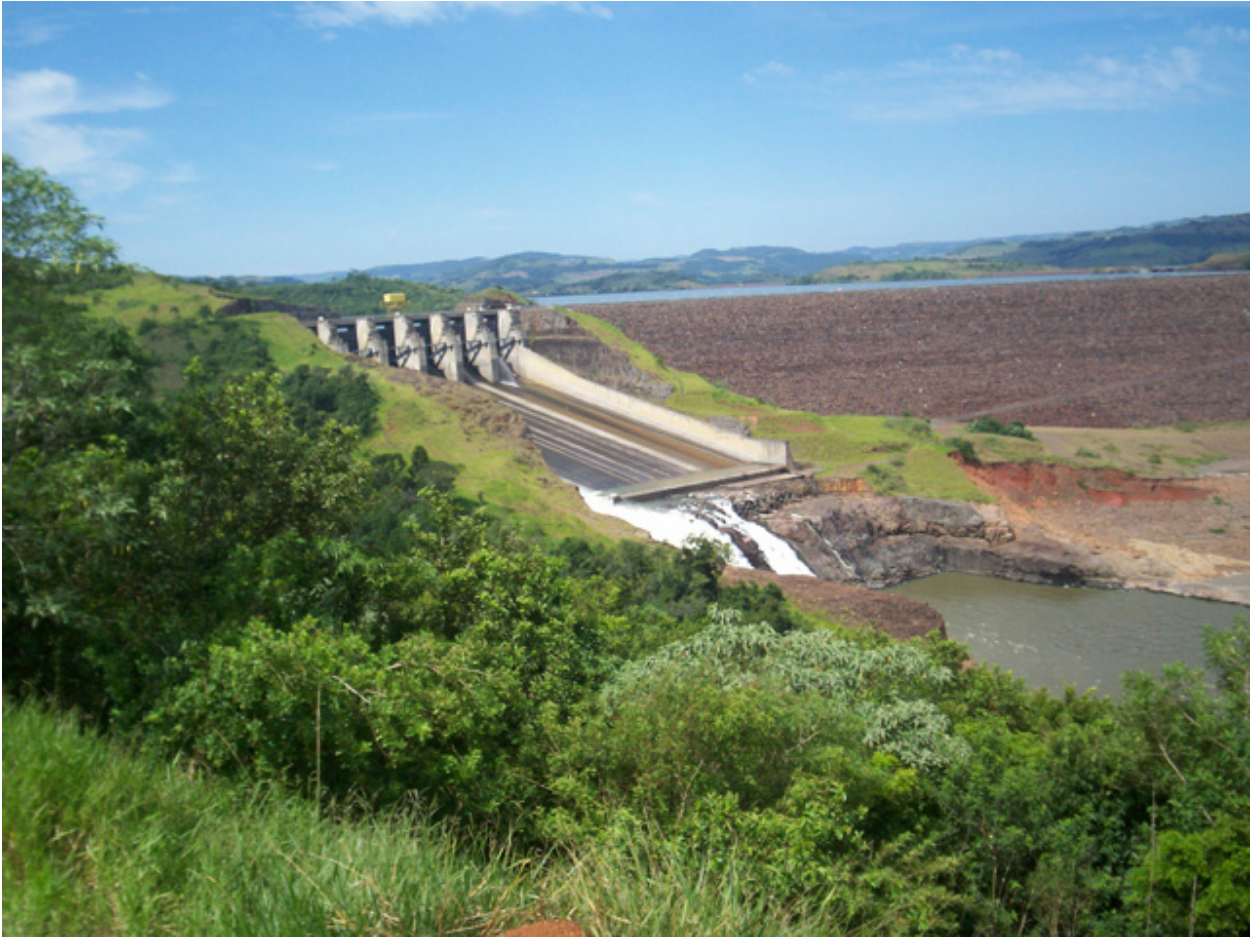
Figura 2.8 - Usina de Itá - Vista do Talude de Jusante e dos Vertedores. Imagem: Adroaldo Dias Robaina e Marcia Xavier Peiter
