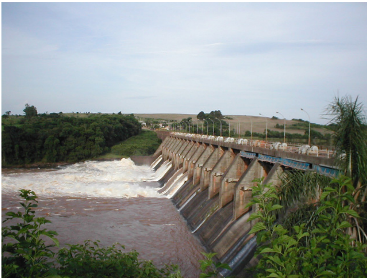
Figura 2.12 – Vista panorâmica da estrutura da Barragem Maia Filho Imagem: Adroaldo Dias Robaina e Marcia Xavier Peiter
