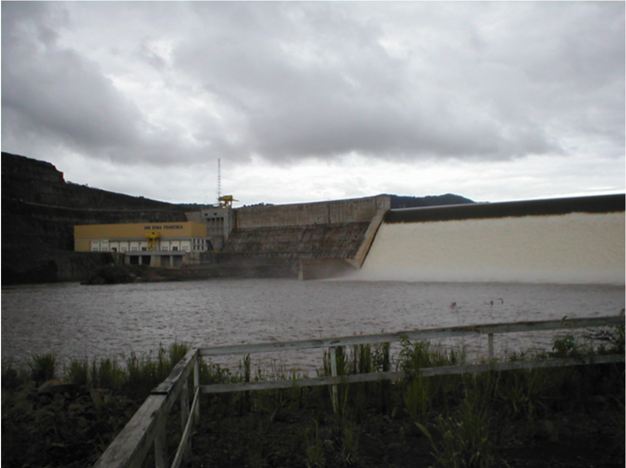
Figura 2.13 - Imagem da estrutura da Barragem de Dona Francisca - Região da Quarta Colônia - RS. Imagem: Adroaldo Dias Robaina e Marcia Xavier Peiter
