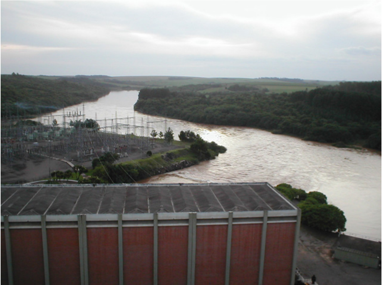
Figura 2.10 – Vista da Usina Hidrelétrica de Passo Real Imagem: Adroaldo Dias Robaina e Marcia Xavier Peiter
