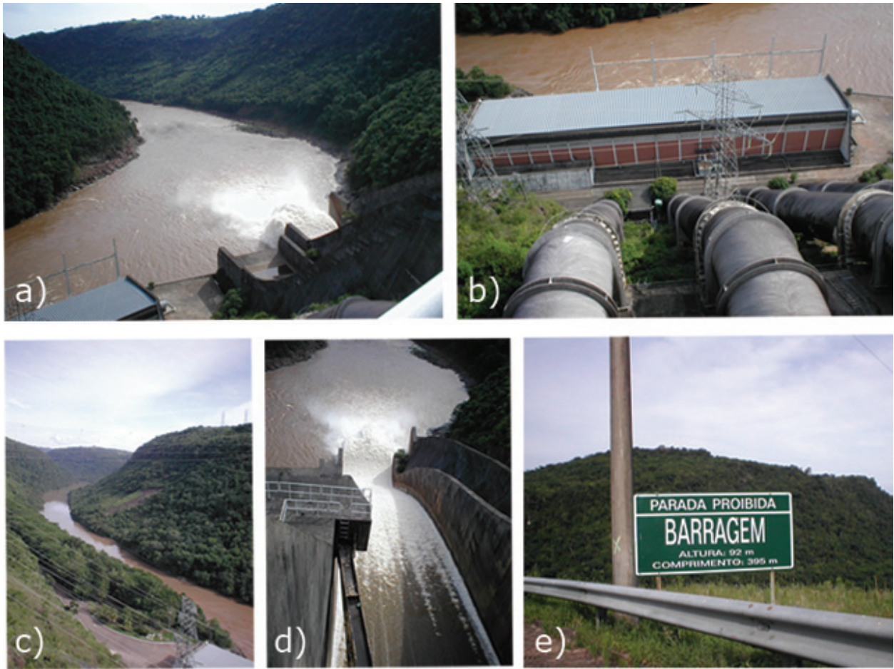
Figura 2.11 – Imagens da Barragem e da Usina Hidrelétrica de Itaúba – Rio Jacuí. Imagem: Adroaldo Dias Robaina e Marcia Xavier Peiter
