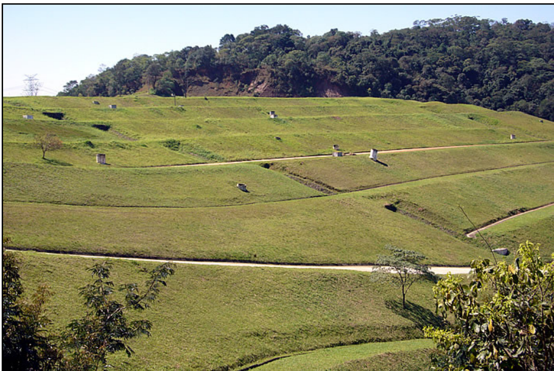
Figura 1- Aterro Sanitário do Saco do Funil – Ampliação Guarujá, SP
