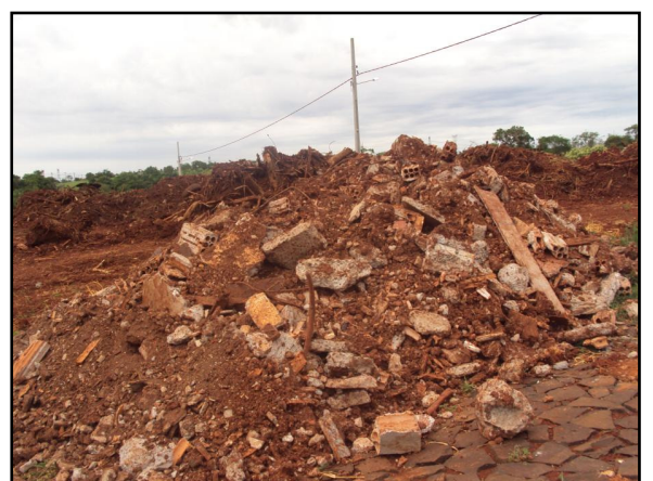
Figura 17 - Local dos resíduos 4-b
