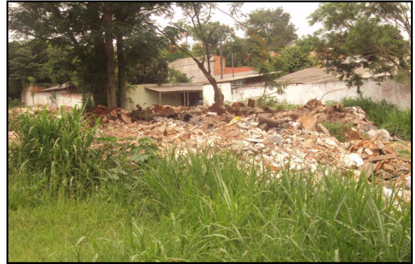
Figura 13 - Local dos resíduos 2-b
