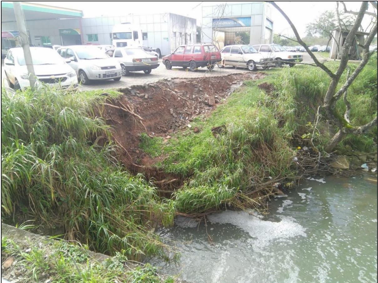
Figura 26 – Assoreamento na margem esquerda da sanga Lagoão do Ouro na Avenida Roraima em agosto de 2017.
