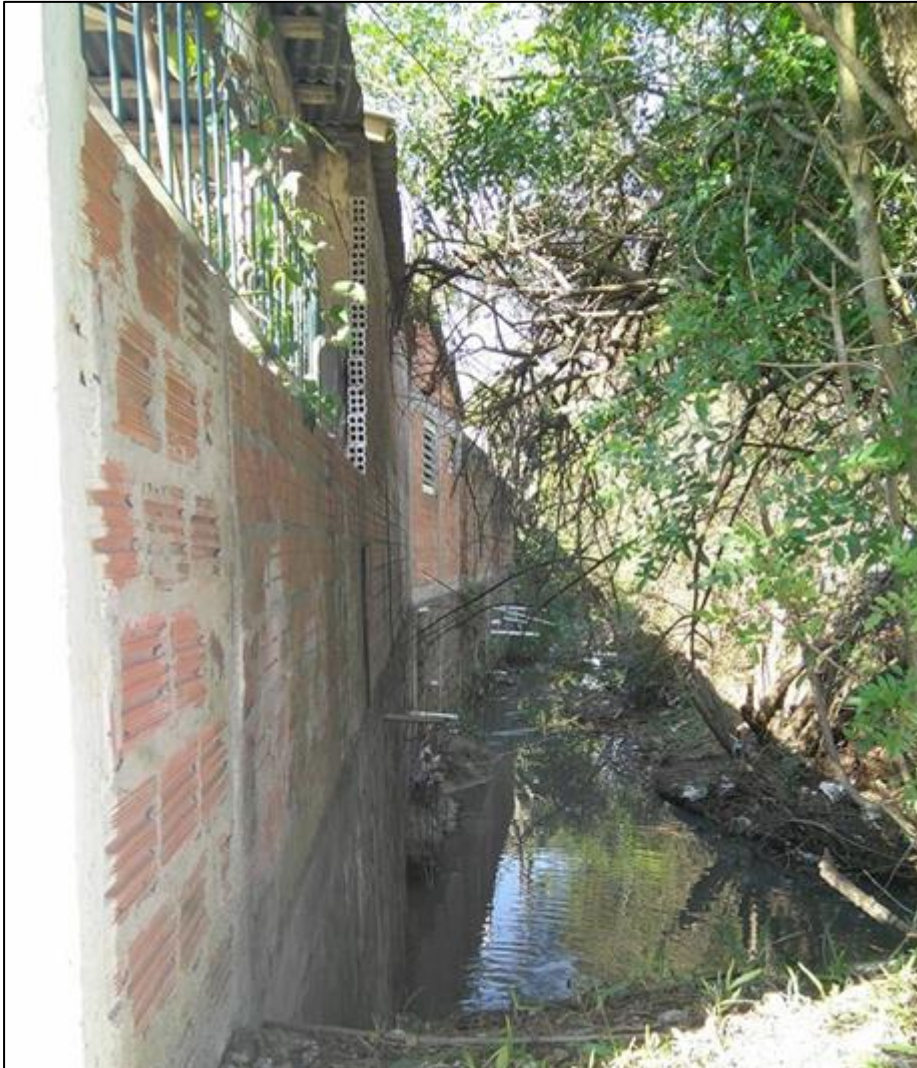
Figura 27 – Lançamento de efluentes domésticos na sanga Lagoão do Ouro na COHAB Fernando Ferrari, bairro Camobi, Santa Maria, RS.
