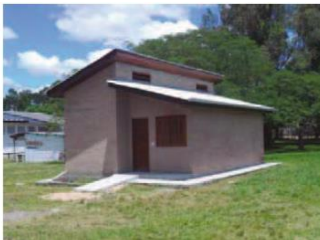
Figura 4 - Fachada Norte e Oeste da casa popular eficiente localizada na UFSM
