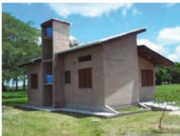
Figura 5 - Fachada Norte e Leste da casa popular eficiente localizada na UFSM
