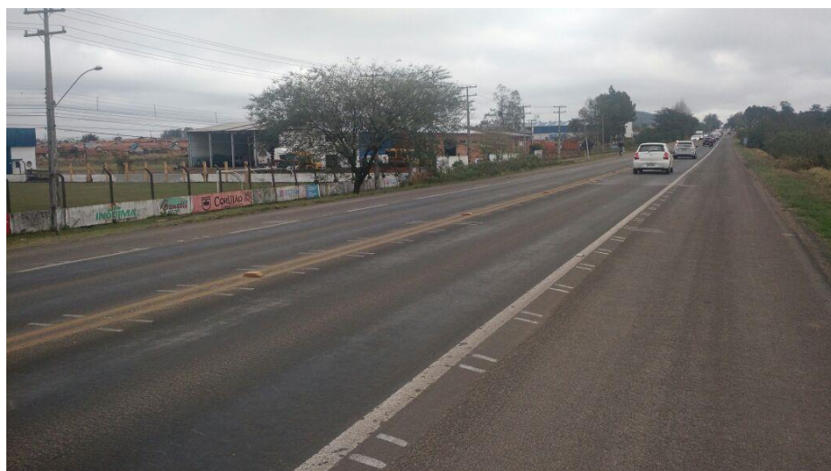
Figura 17 - Pontos de análise demarcados na via.
