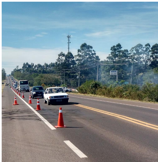
Figura 1 - Exetmplo de rodovia dotada de sinalização horizontal (linhas de eixo e de bordo).
