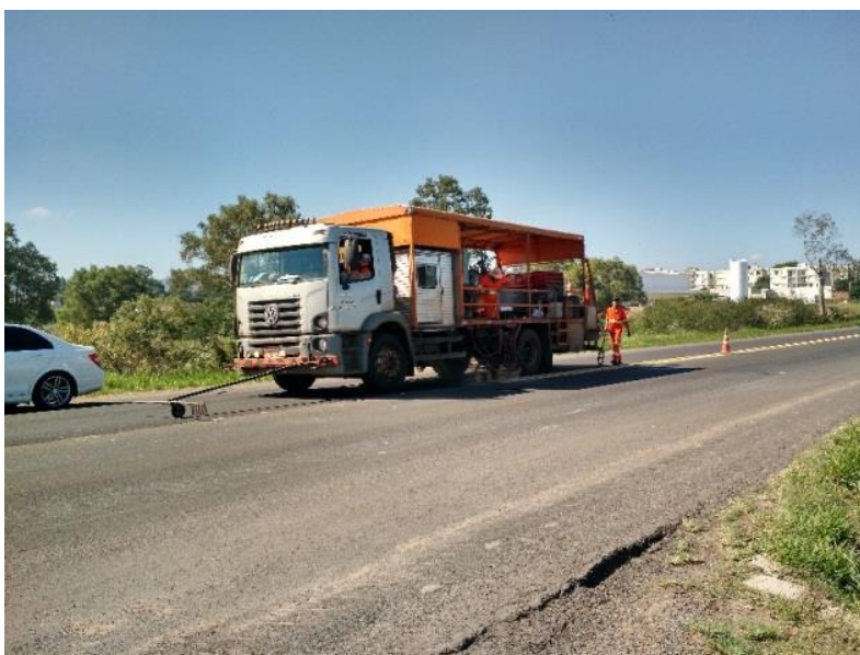
Figura 15 - Equipe de pintura realizando demarcação no segmento escolhido.
