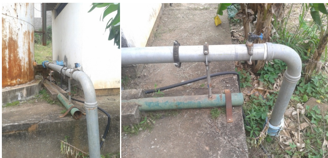
Figura 8 – Intercepção da rede de sucção das bombas
