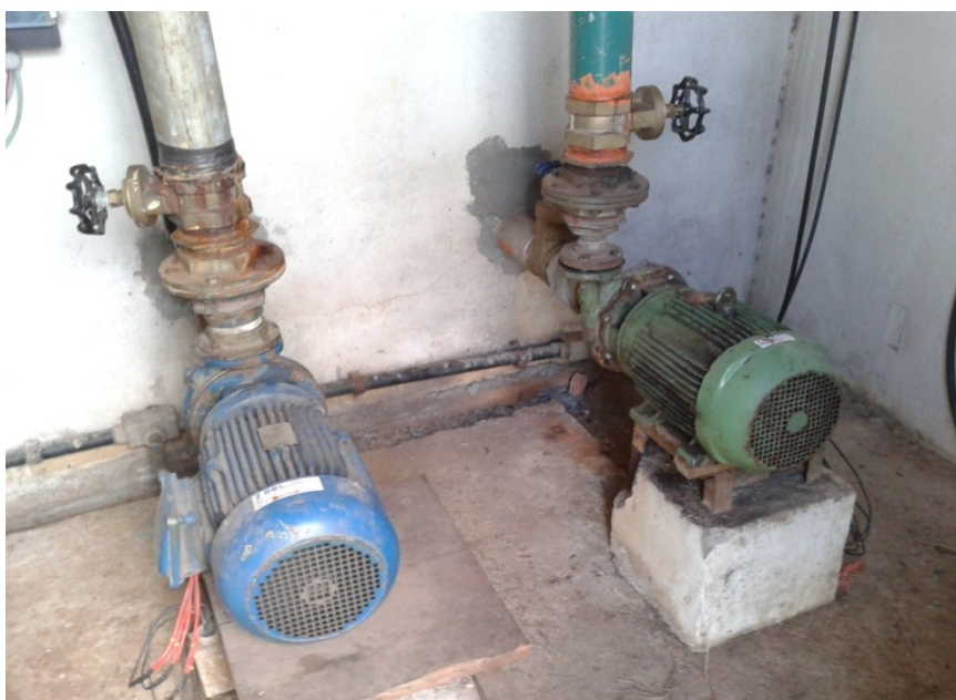
Figura 6 – Configuração antiga do booster Roselândia
