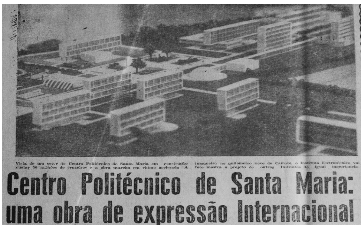
Figura 11 – Centro Politécnico como obra de expressão internacional.
