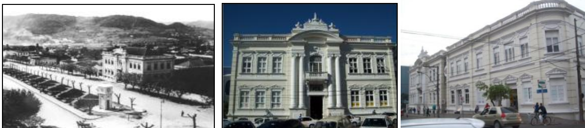
Figura 64 - Escola de Artes e Ofícios (Hugo Taylor) no século XIX e atualmente, onde funciona o Supermercado Carrefour
