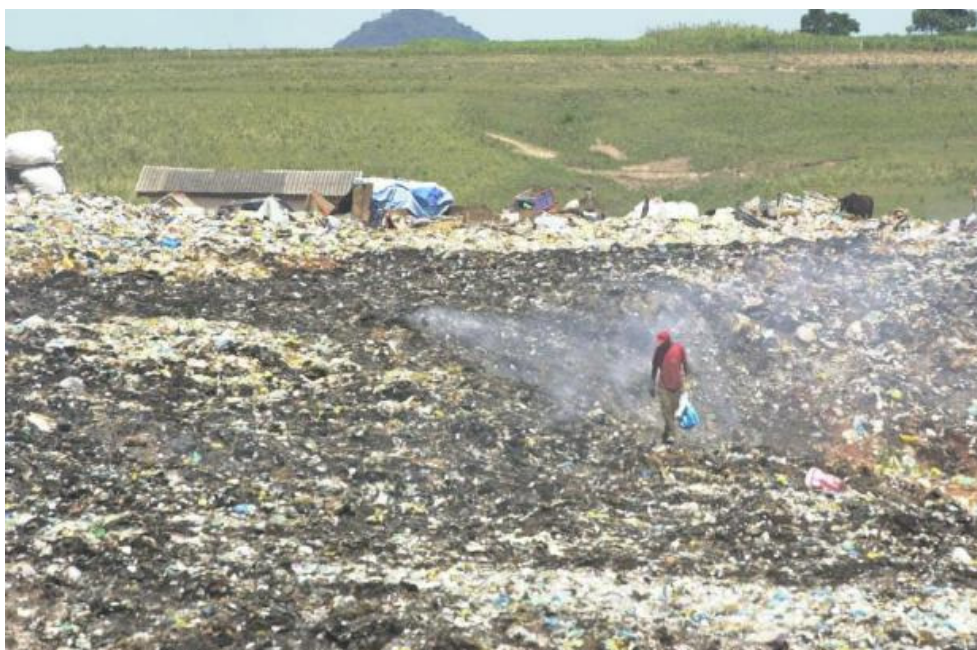
Figura 32 – Central de Tratamento de Resíduos de Santa Maria
