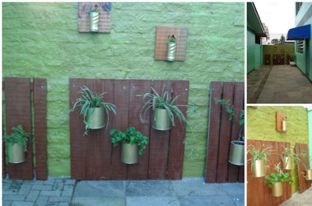
Figura 8: Revitalização do muro que dá acesso à sala multifuncional.
