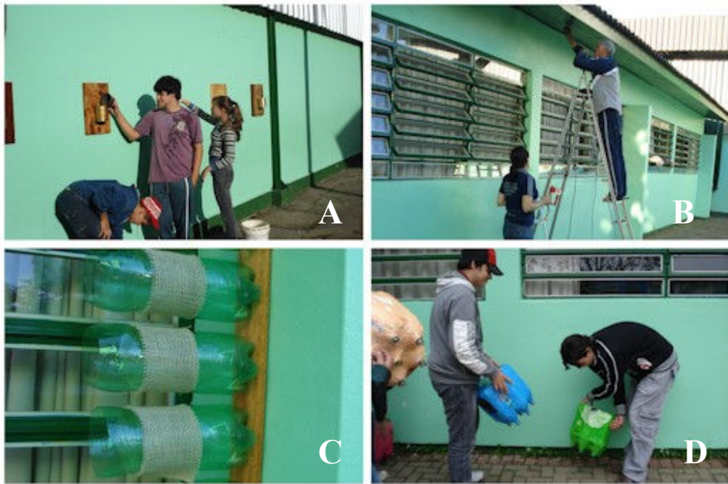
Figura 7: Segunda etapa da reconstrução do pátio - colocação dos quadros da parede do ginásio (A), dos comedouros para pássaros (B) e do revisteiro (C). Disposição dos puffes (D).
