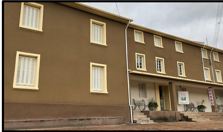
Figura 16 – Fachada lateral da Casa Paroquial, entrada principal do MIEM
