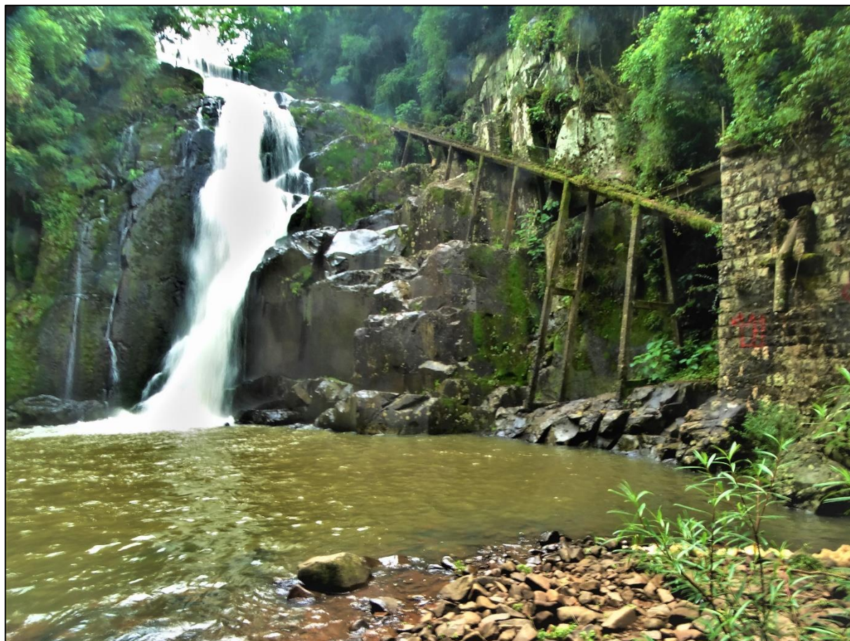
Figura 15: Cascata da Usina
