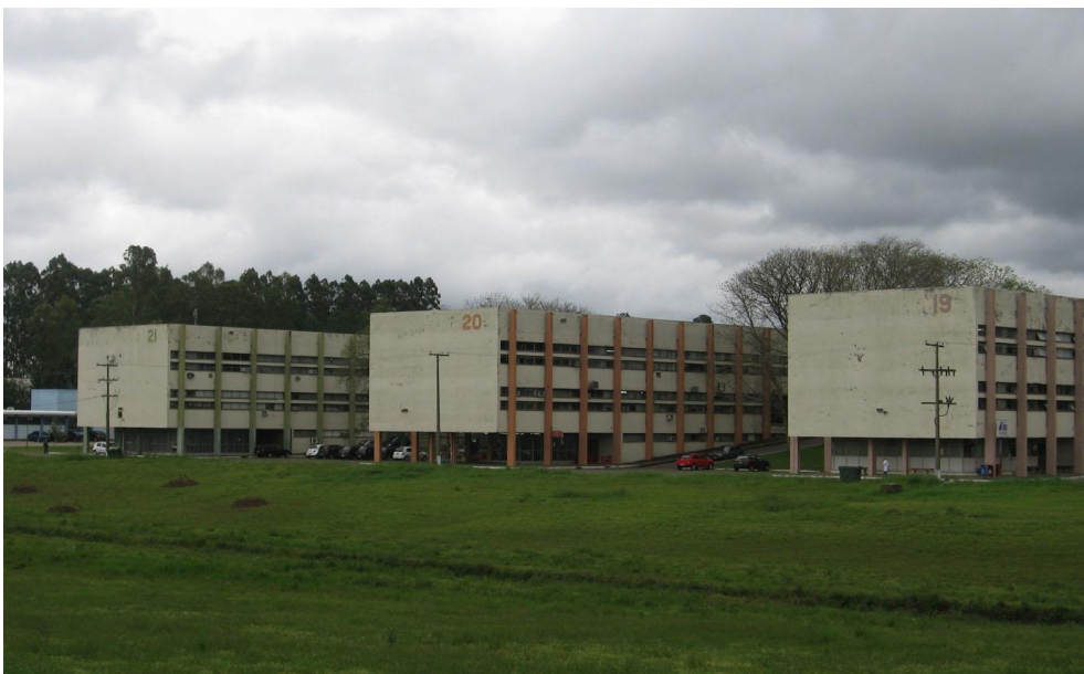
Figura 27 . Fotografias dos Prédios Básicos.
