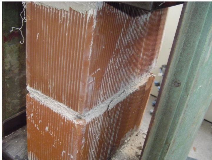
Figura 19 – Ruptura por esmagamento da junta de um prisma ensaiado por De Lima (2010)
