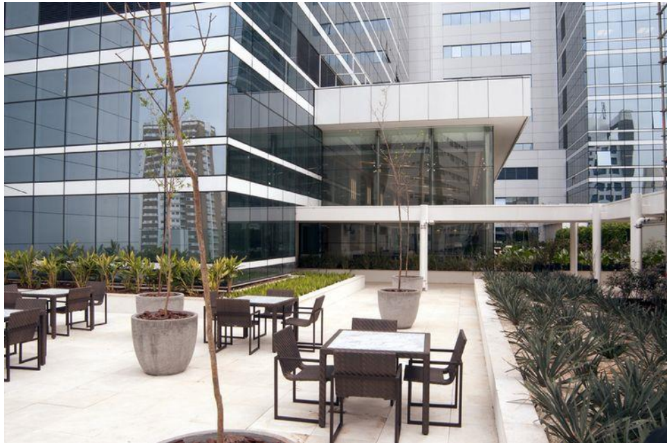
Figura 17- Terraços com jardins em uma das coberturas do Hospital Sírio Libanês.
