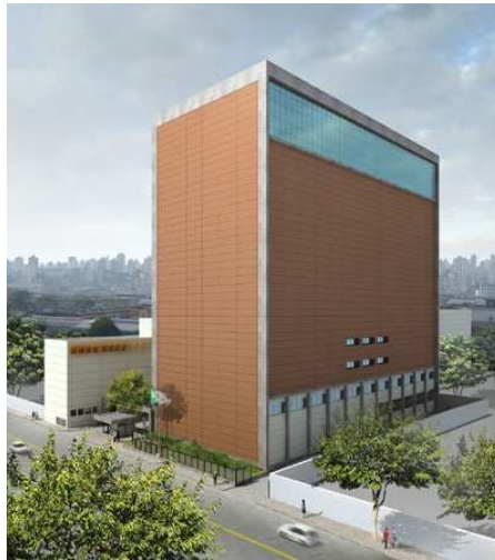
Figura 7 - Nova Sede do Arquivo Público do Estado de São Paulo
