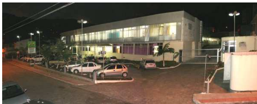
Figura 6 - Prédio do Arquivo Público do Estado de Santa Catarina Fonte: Arquivo Público do Estado de Santa Catarina
