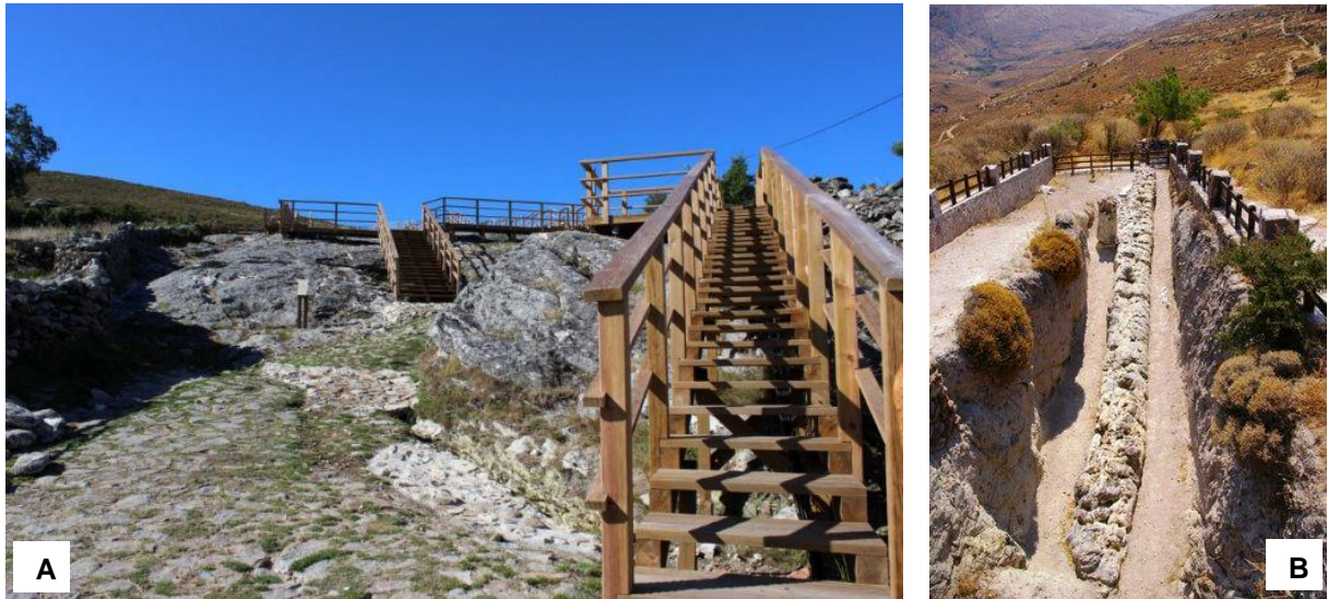
Figura 6 – estruturas construídas para auxiliar na geoconservação
