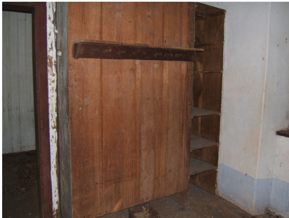
FIGURA K - Armário embutido em parede na casa de Johann Brill e Angela Klesen.
