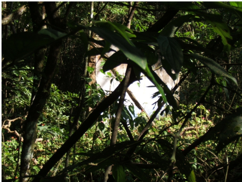
FIGURA M - Esta parede erguida no meio do matagal pertencia à cozinha da casa da Família Brill.
