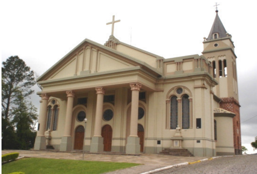
Figura 3 - Vista da fachada frontal da igreja Matriz Corpus Christi de Vale Vêneto-município de São João do Polêsine-RS.
