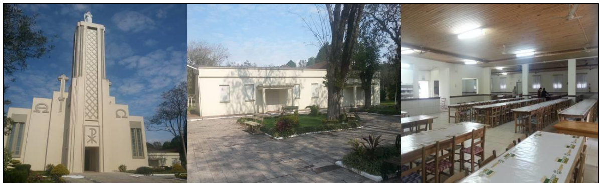
Figura 3 – Capela Anjo da Guarda e o Salão Comunitário de Santos Anjos
