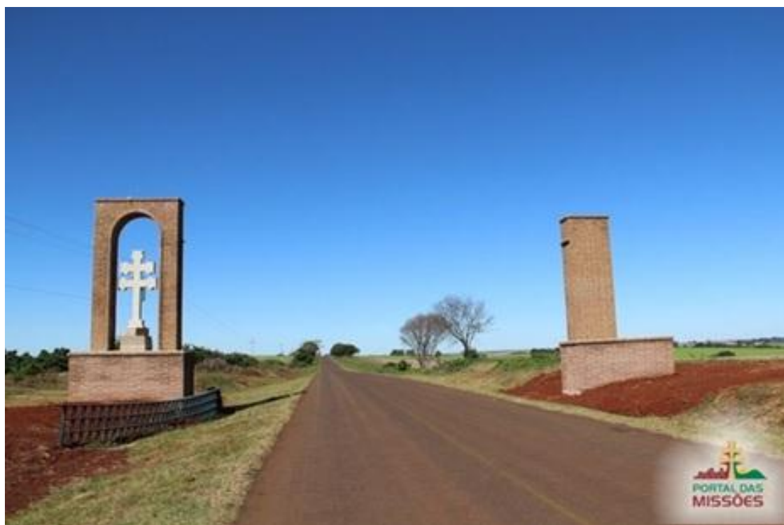
Figura 27 – Pórtico em construção, São Nicolau, RS
