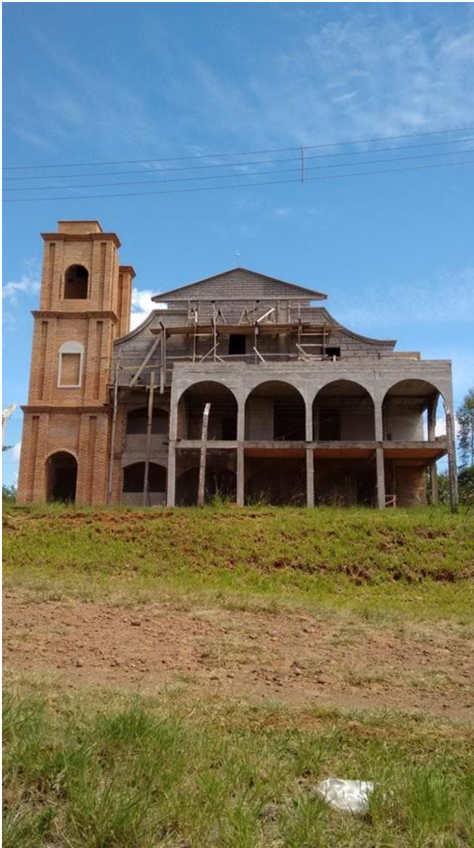
Figura 6 – Hotel em construção nas margens da BR 285
