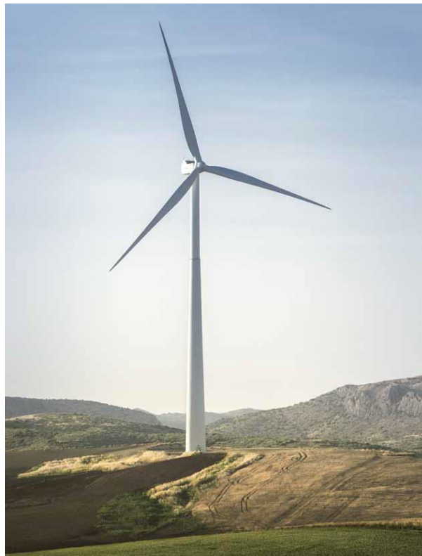
Figura 7 - Turbina de eixo horizontal: GAMESA 5.0 MW.
