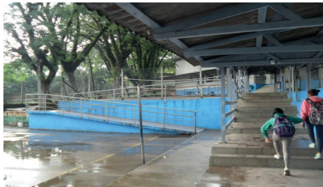
Figura 4: Rampa de acesso para as salas de aula e pátio.
