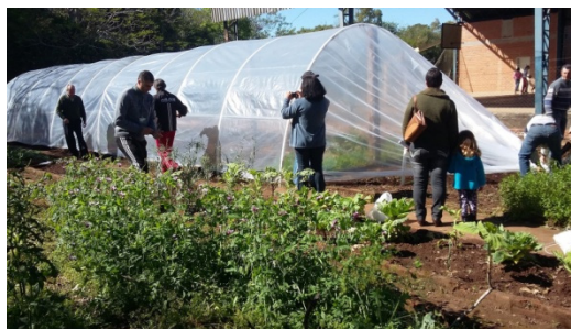
Figura 46 – Mutirão para a construção da estufa
