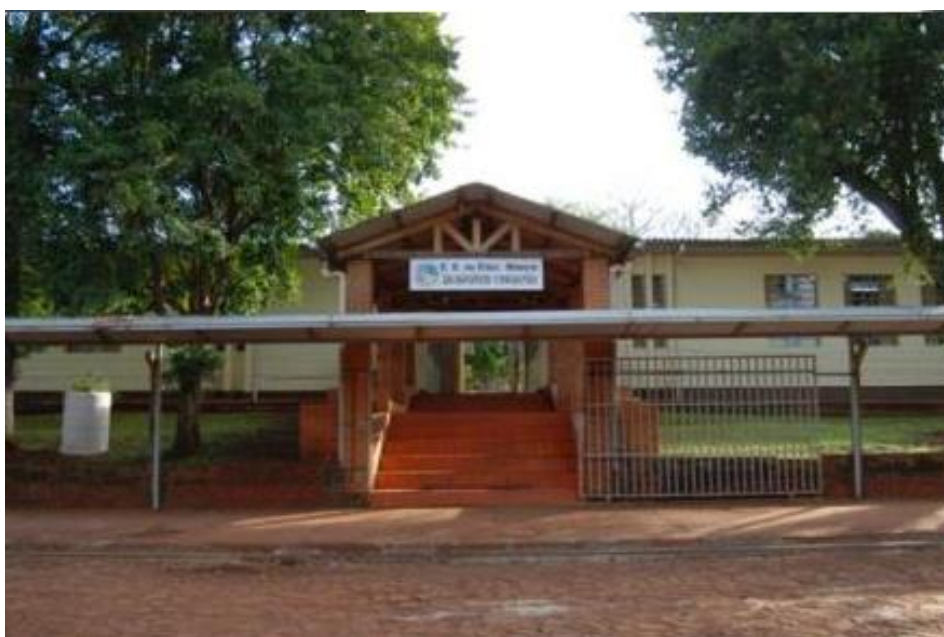
Figura 24 - Fachada da escola Ermindo Vier
