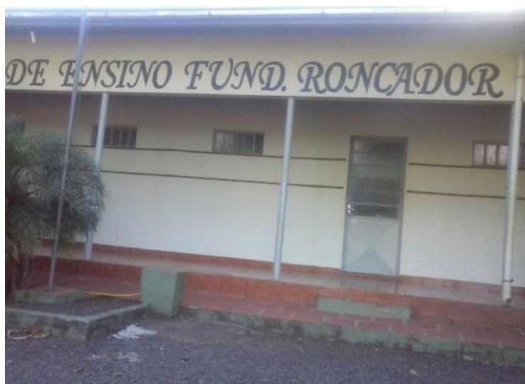
Figura 20 - Fachada da escola Roncador
