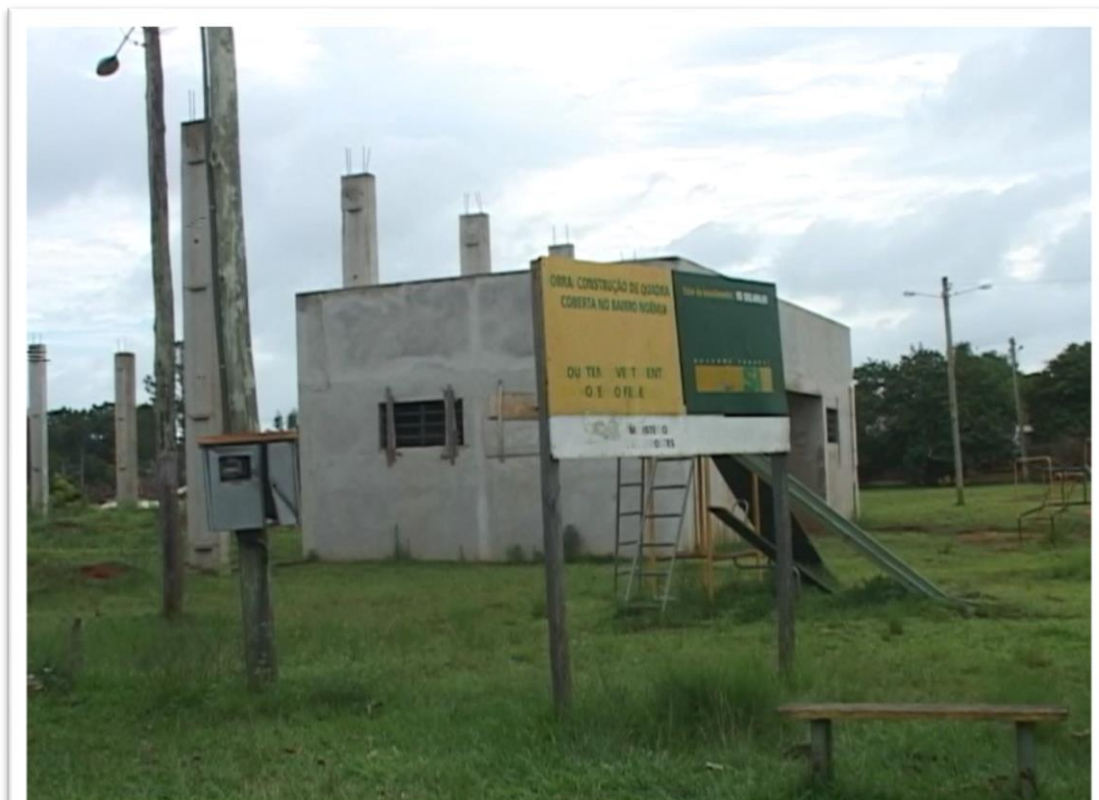
Figuras 25 e 26 - Obra paralisada de ginásio no Bairro Noêmia
