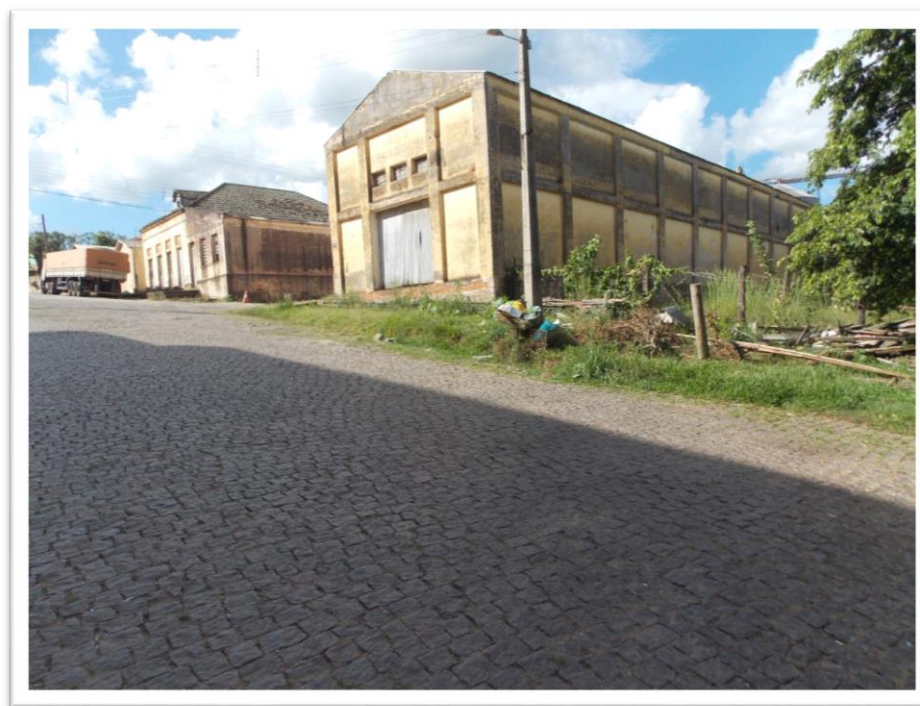
Figura 31 – Prédios abandonados de cooperativas cerealistas às margens do Rio Jacuí
