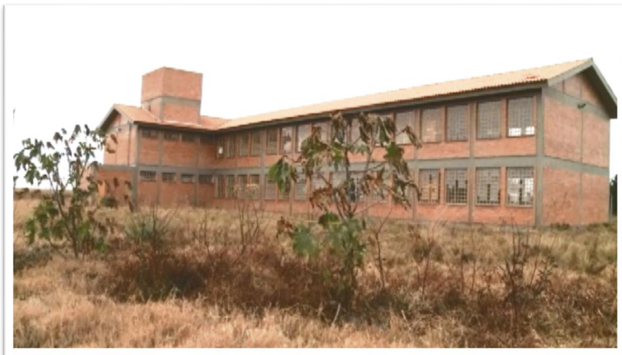
Figura 24 - Escola na Vila Piquiri
