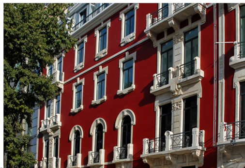
Figura 17 – Detalhe das aberturas do Edifício 240
