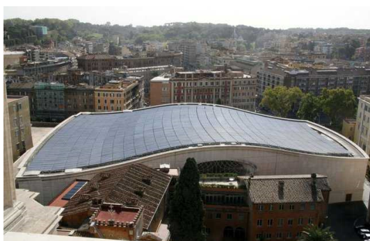
Figura 14 - Módulos FV instalados na cobertura do Palácio Apostólico
