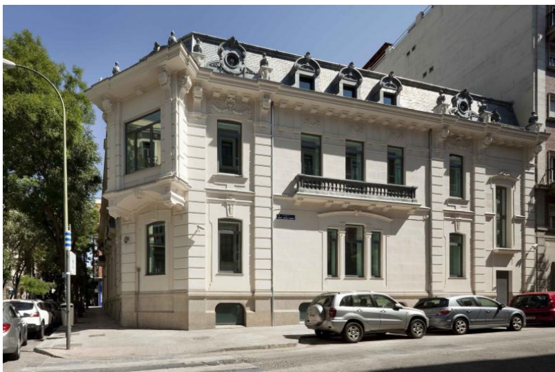
Figura 21 - Fachada lateral da edificação
