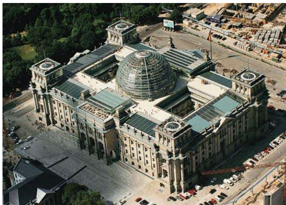
Figura 10 - Módulos FV instalados na cobertura do Parlamento Alemão.
