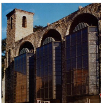
Figura 6 - Sistema instalado na fachada da edificação
