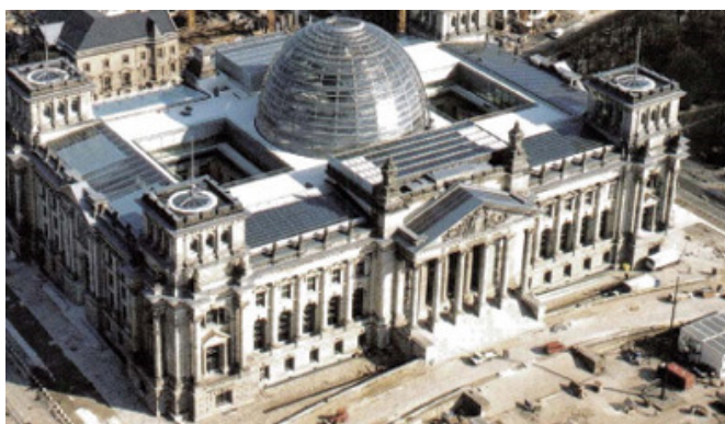
Figura 11 - Módulos FV instalados na cobertura do Parlamento Alemão.
