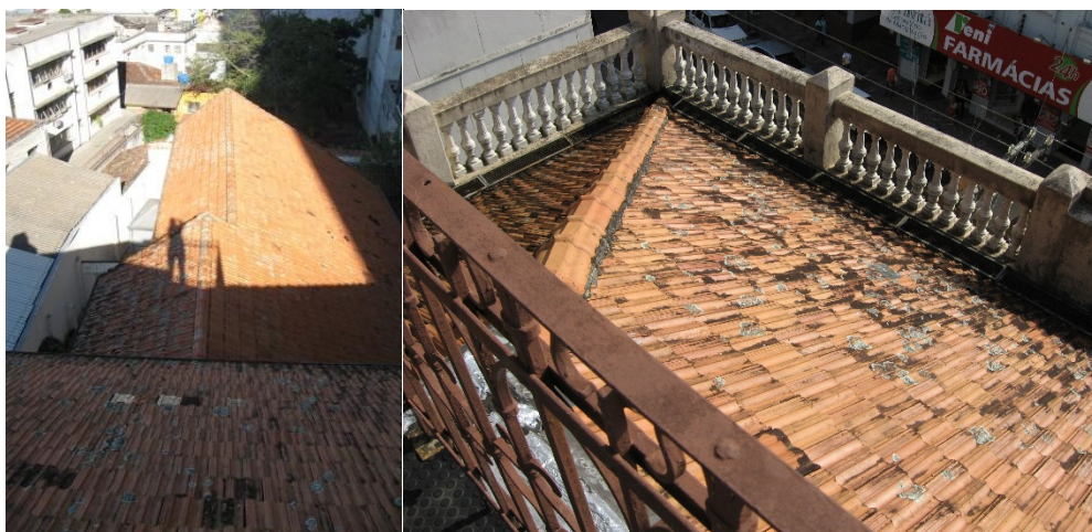
Figura 60 - Cobertura do Palacete Dr. Astrogildo de Azevedo
