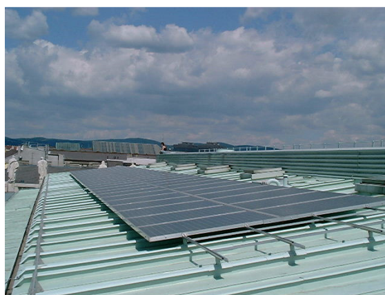
Figura 8 - Detalhe da estrutura em alumínio para fixação dos módulos.
