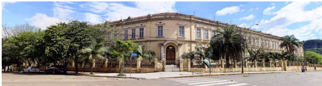
Figura 37 - Vista geral da fachada do Colégio Manoel Ribas
