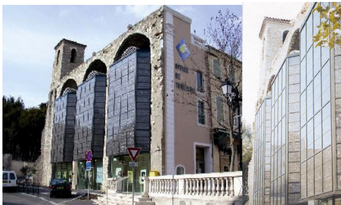
Figura 5 - Detalhe da fachada com instalação fotovoltaica.
