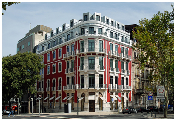
Figura 16 – Fachada frontal Edifício 240, Avenida da Liberdade
