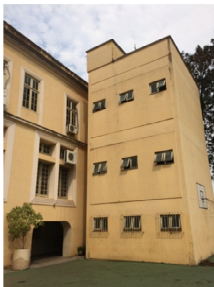
Figura 38 - Edificação anexa onde foram posicionados os sanitários.
