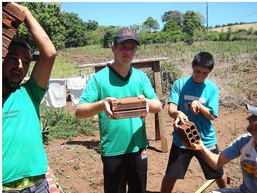
Figura 10 – Construção da composteira.
