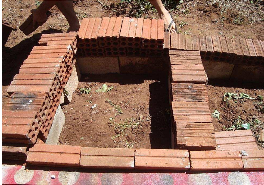
Figura 11 – Construção da composteira dividida ao meio.
