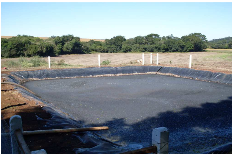
Figura 2.1 – Esterqueira com lona de PEAD, cercada. Marau-RS. Data 05/04/2011.
