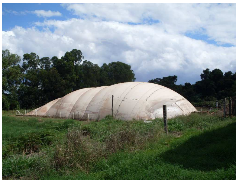
Figura 2.3 – Biodigestor. Ibirubá. Data 01/04/2011.
