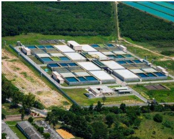
Figura 1 – Estação de tratamento de esgoto sanitário estudada
