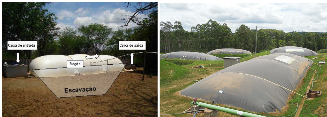
Figura 10 - Biodigestor modelo Canadense instalados em propriedade rural
