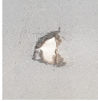
Figura 25 – Buraco no asfalto no viaduto da UFSM e detectado por \lambda_{sup} e \lambda_{inf} durante o experimento neste cenário.
