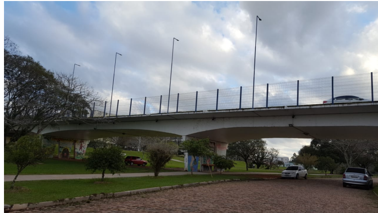
Figura 23 – Visão geral do viaduto interno da UFSM.
